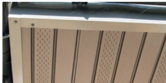
Пример подшивки карниза металлическими софитами
