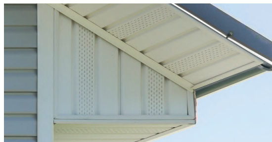
Пример подшивки карниза пластиковыми софитами
